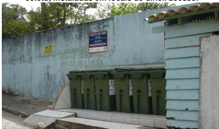
Figura 13: Exemplo de Lixeira Comunitária para disposição dos resíduos sólidos à coleta, instaladas em locais de difícil acesso.
