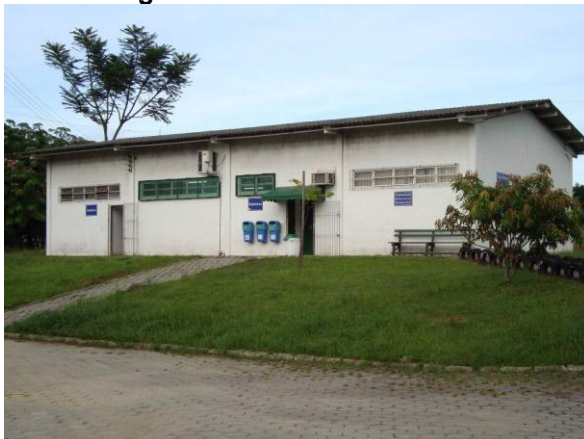
Figura 58: Vista geral do Refeitório e Sala de Treinamento
