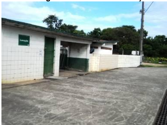
Figura 57: Vista geral da Unidade de Lavagem da Frota
