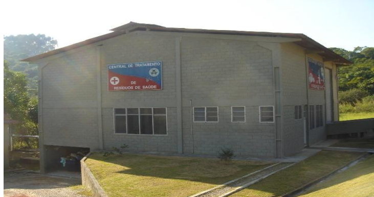
Figura 96: Central de Tratamento de Resíduos de Serviços de Saúde.
