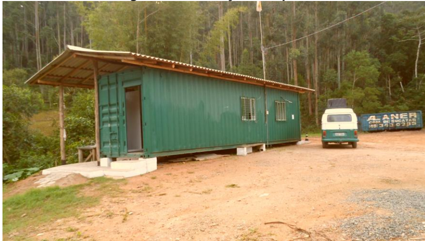
Figura 85: instalação de Apoio.
