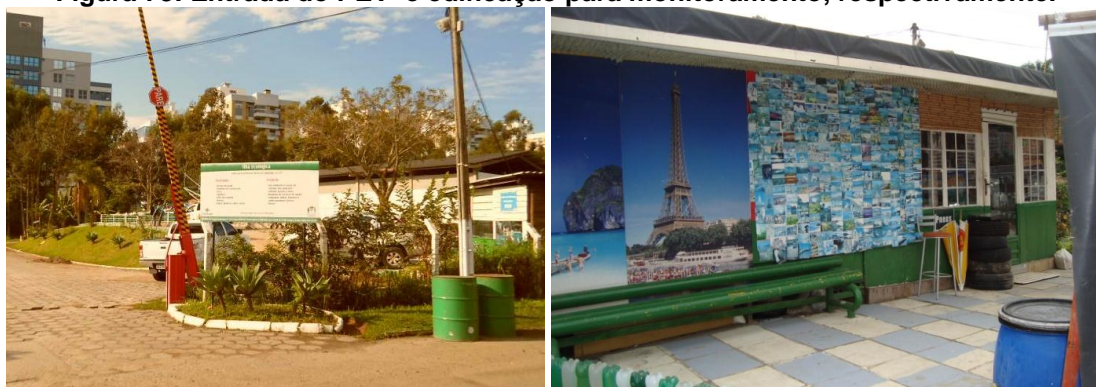
Figura 78: Entrada do PEV e edificação para monitoramento, respectivamente.
