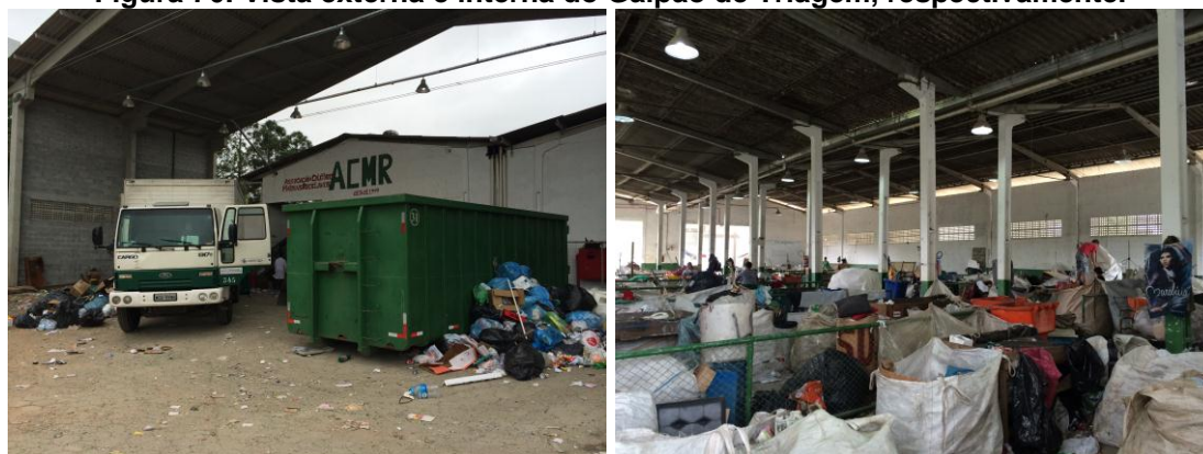
Figura 76: Vista externa e interna do Galpão de Triagem, respectivamente.
