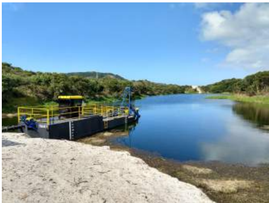
Figura 7. Visão geral da LEI e do sistema de dragagem. (Foto: 31/08/2021)
