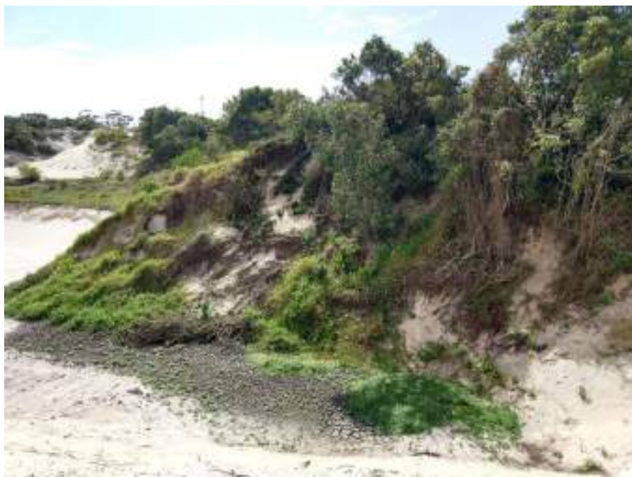
Figura 5. Talude a jusante da ensacadeira, situado a leste da área úmida (Foto: 31/08/2021).
