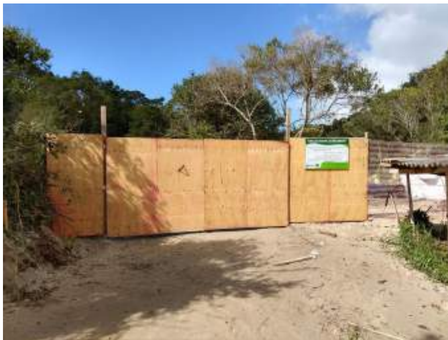
Figura 1. Delimitação da área do PRAD e controle de acesso a LEI (Foto: 31/08/2021)
