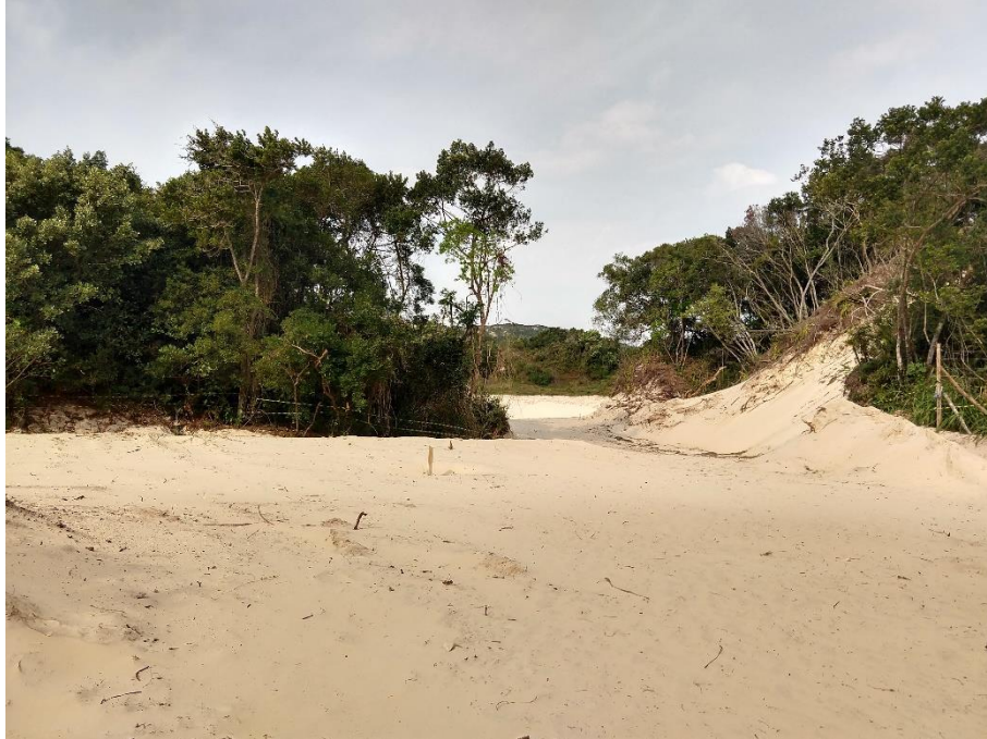
Figura 1. Acesso a LEI, após conformação de terreno para circulação de maquinário (Foto: 18/08/2021)
