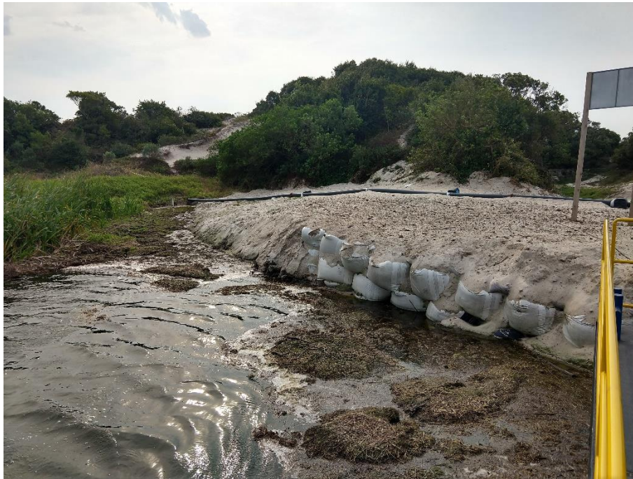
Figura 7. Vista de montante da ensacadeira no setor oeste, nível d'água na cota de 9,35m (Foto: 18/08/2021)
