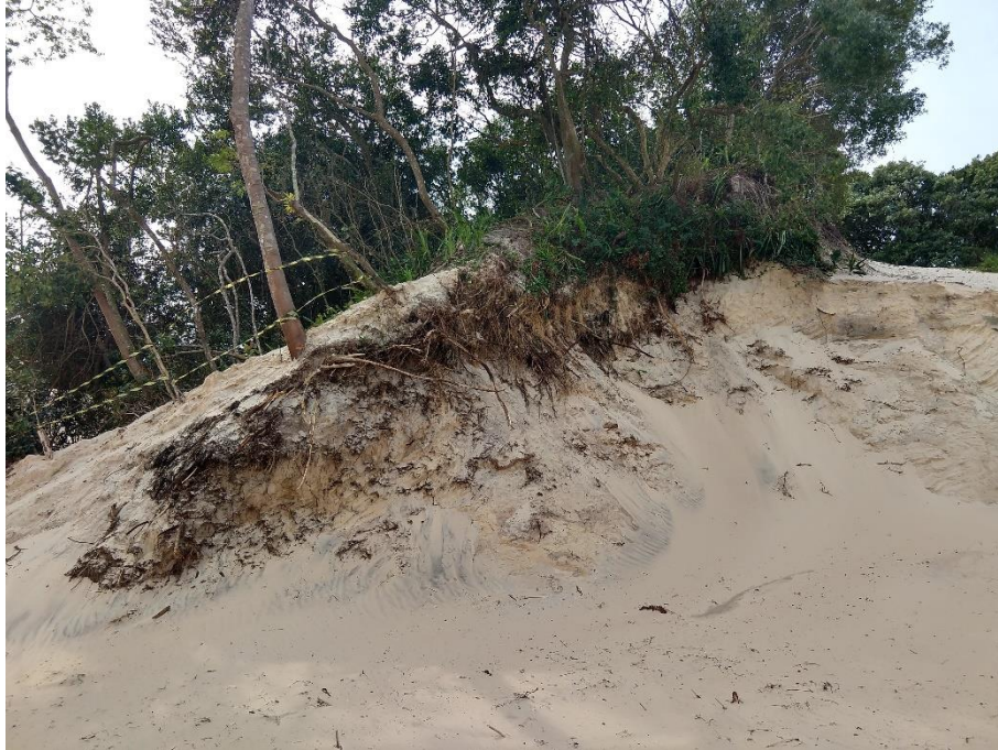
Figura 3. Situação do talude adjacente ao acesso – lateral norte (Foto: 18/08/2021)
