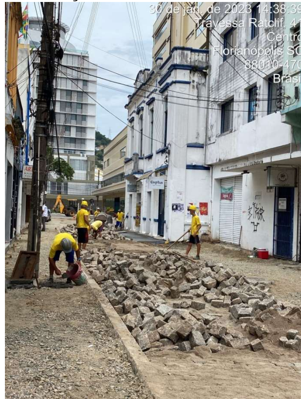
Obras no Centro-Leste são vistoriadas pela CGM
