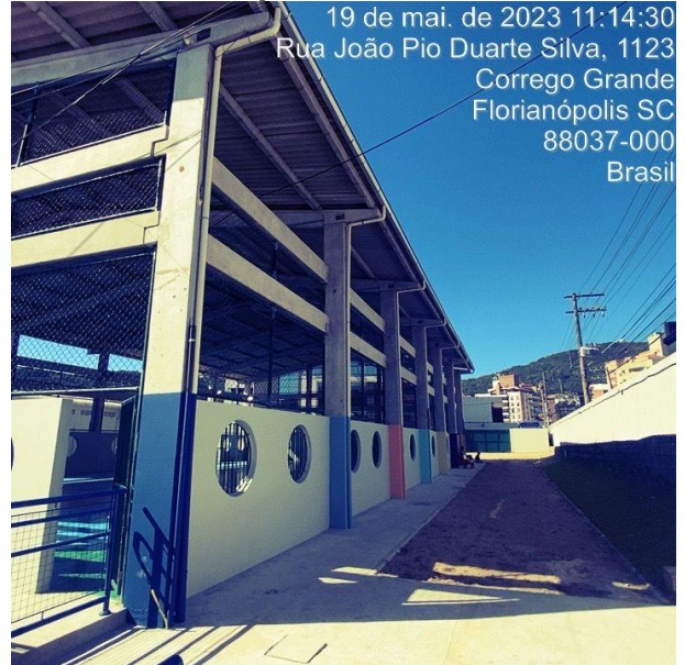
Obras recebem visita no dia 19 de maio
