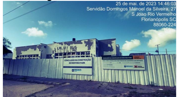
Obras do NEIM Red Park recebem visita da CGM
