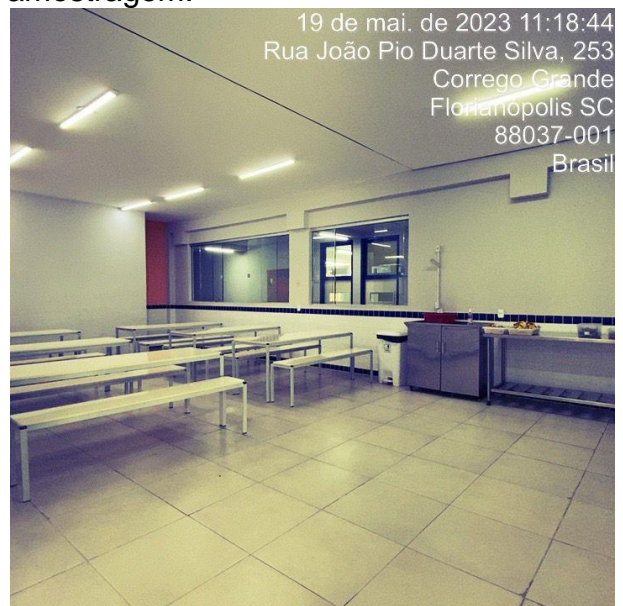
Obras estão em fase final
