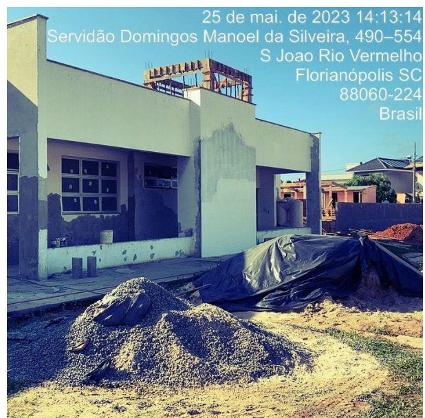
Obras do NEIM Red Park recebem visita da CGM
