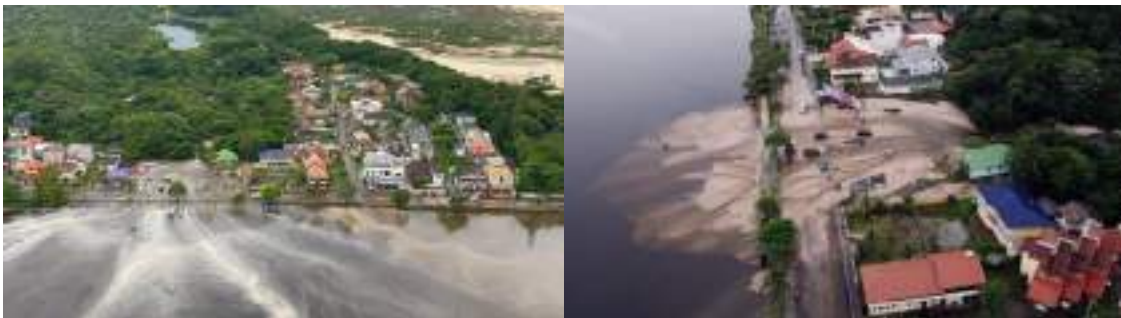
Imagens do momento do rompimento da lagoa de evapoinfiltração no dia 25/01/2021.
