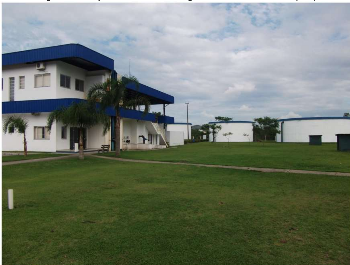
Figura 50: Estação de Tratamento de Água de Jurerê Internacional (ETA)
