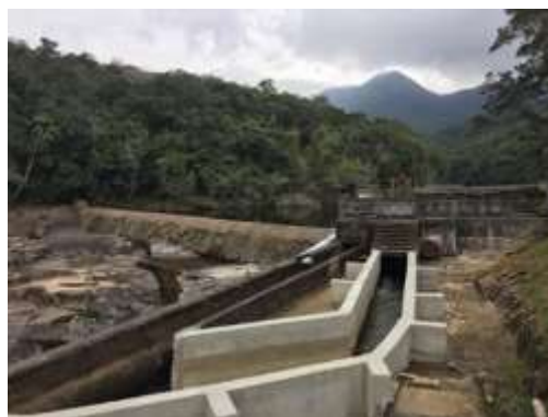
Figura 20: Barragem de captação no Rio Vargem do Braço
