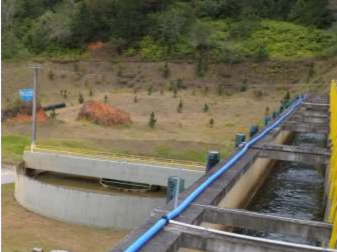
Figura 31: Adensador do lodo
