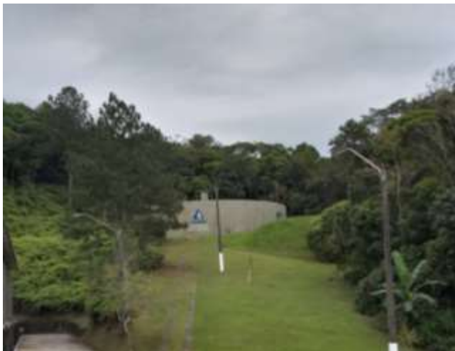
Figura 37: Reservatório para lavagem dos filtros
