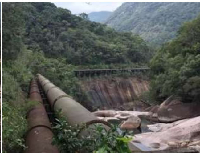
Figura 23: adutoras de água bruta
