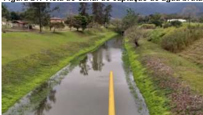
Figura 21: Vista do canal de captação de água bruta.
