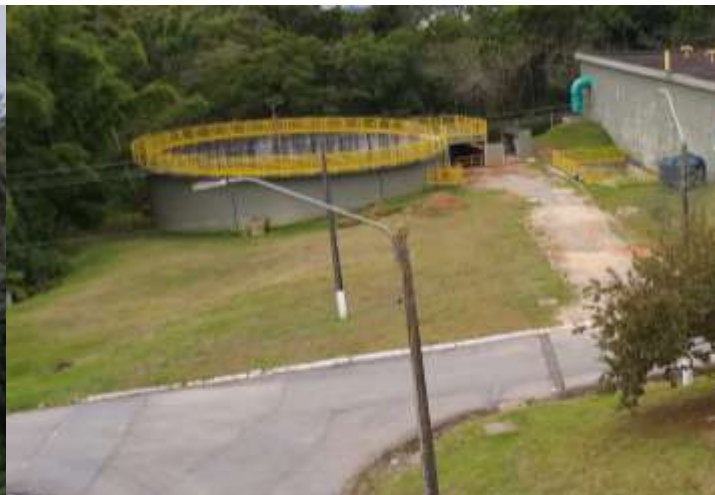
Figura 38: Tanque de Equalização
