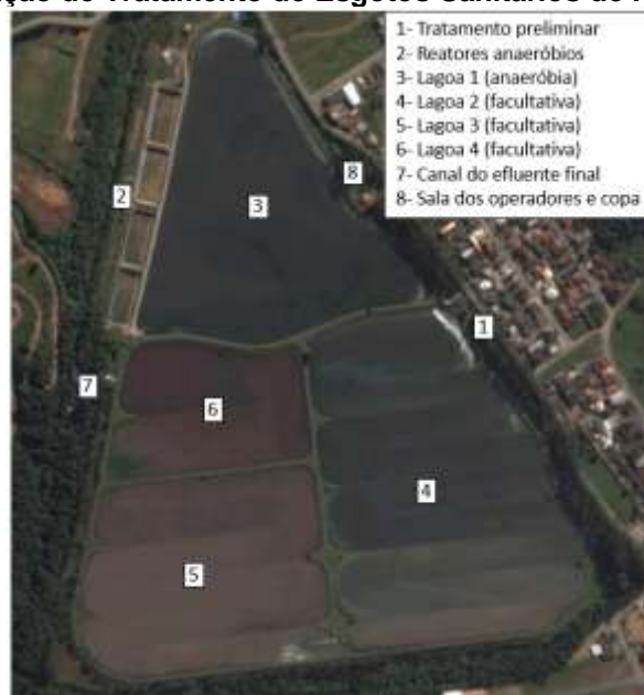
Figura 56: Estação de Tratamento de Esgotos Sanitários de Potecas (SESFC).
