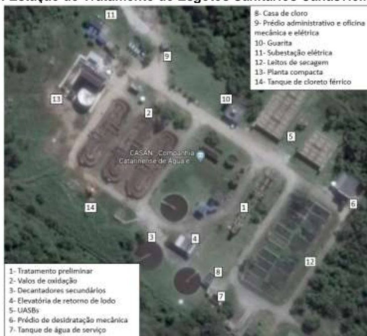
Figura 68: Estação de Tratamento de Esgotos Sanitários Canasvieiras (SESC).
