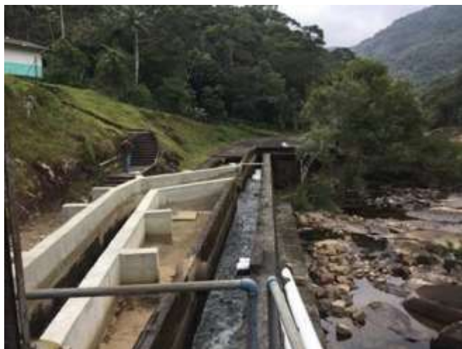
Figura 22: vista do canal de captação
